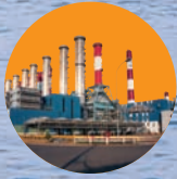
UP GRESIK Total Kapasitas: 2.239 MW
