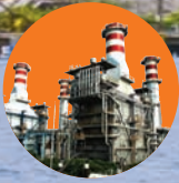
UP MUARA KARANG Total Kapasitas: 909 MW
